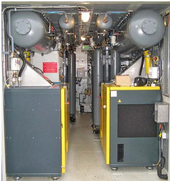
L'objectif est de remplir sur le terrain, des bouteilles d'oxygène en grande quantité, sous une pression de 200 bars au profit des équipes médicales d'un hôpital médico-chirurgical (HMC 150 lits) et avec la qualité dictée par la pharmacopée européenne ( $O_2$  à 93 %).
